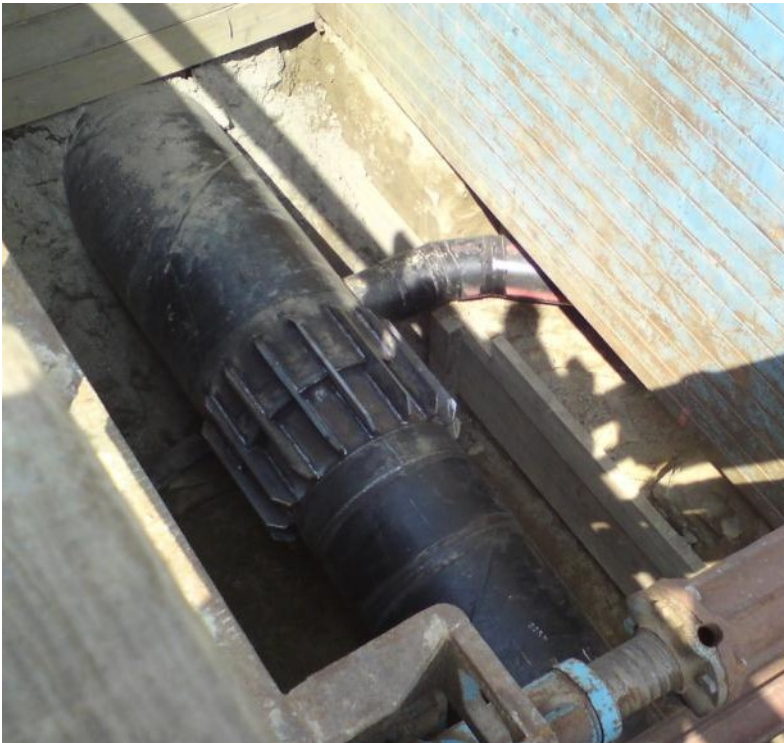
Endstück Wärmetauscher
