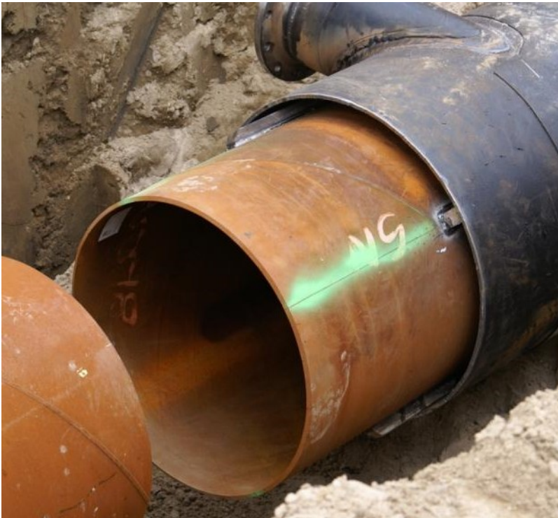
Doppelmantelrohrwärmetauscher
