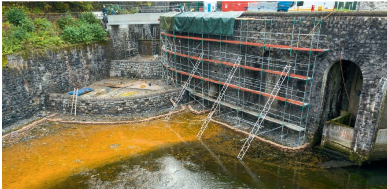
Die Hochwasserentlastung der Sorpetalsperre musste für die Sanierung weitgehend eingerüstet werden.
