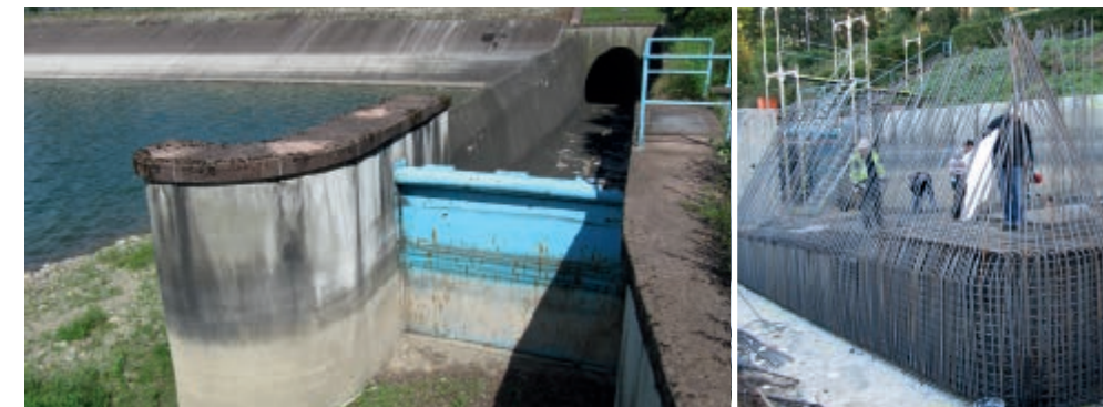
Links: Das rund 60 Jahre alte Stirnschütz der Hennetalsperre vor Beginn der Bauarbeiten. Rechts: Arbeiten an der bewehrten Bodenplatte in der Baugrube.
