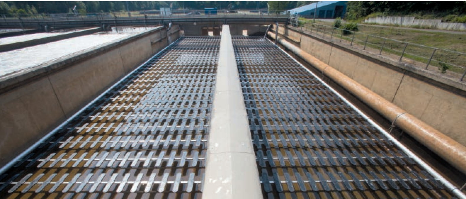
Die Belüftungstechnik in der biologischen Reinigungsstufe der Kläranlage Bochum-Ölbachtal wird umfassend erneuert.
