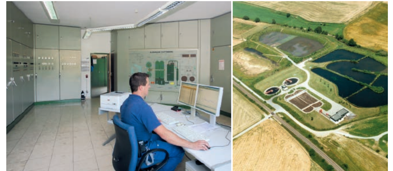
Satellitenanlagen wie die Kläranlage Neuenrade (rechts) werden im Rahmen eines Pilotprojekts von einem Arbeitsteam auf den besetzten Anlagen Plettenberg (links) und Werdohl mitbetreut.
