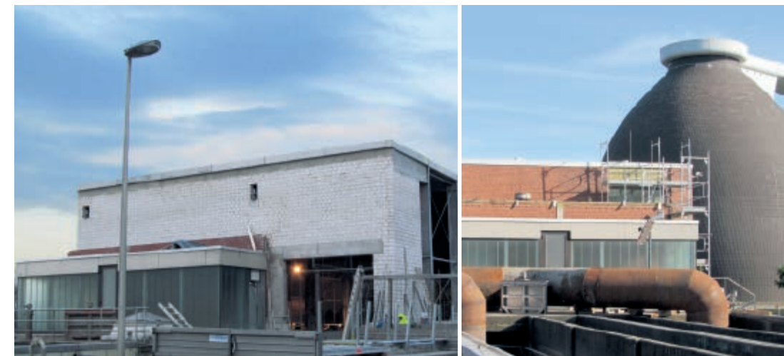
Links: Kläranlage Paderborn, Anbau Rechengebäude. Rechts: Kläranlage Paderborn, Umleitung des Zulaufs mittels einer Heberanlage.
