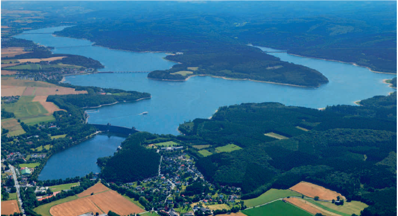
Bild 6.4: Luftaufnahme der Möhnetalsperre Fig. 6.4: Aerial photograph of the Möhne Reservoir
