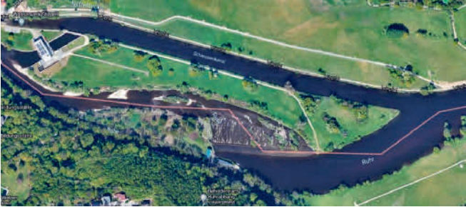
Bild 18.2: Luftaufnahme der Wasserkraftanlage Bochum-Stiepel und Umgebung Fig. 18.2: Aerial view of the hydropower station Bochum-Stiepel and its surroundings
