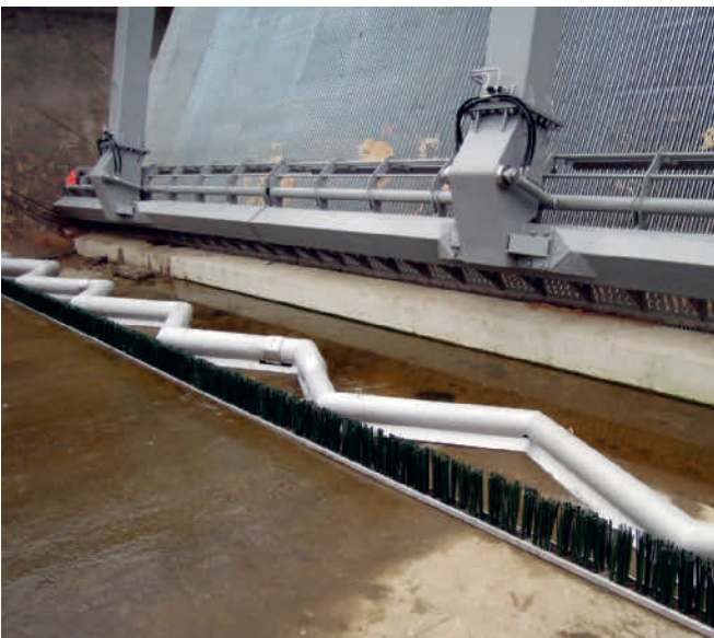
Bild 18.3: Aalfluchtrohr vor der Rechenanlage Fig. 18.3: Escape pipe for eels in front of the screening system
