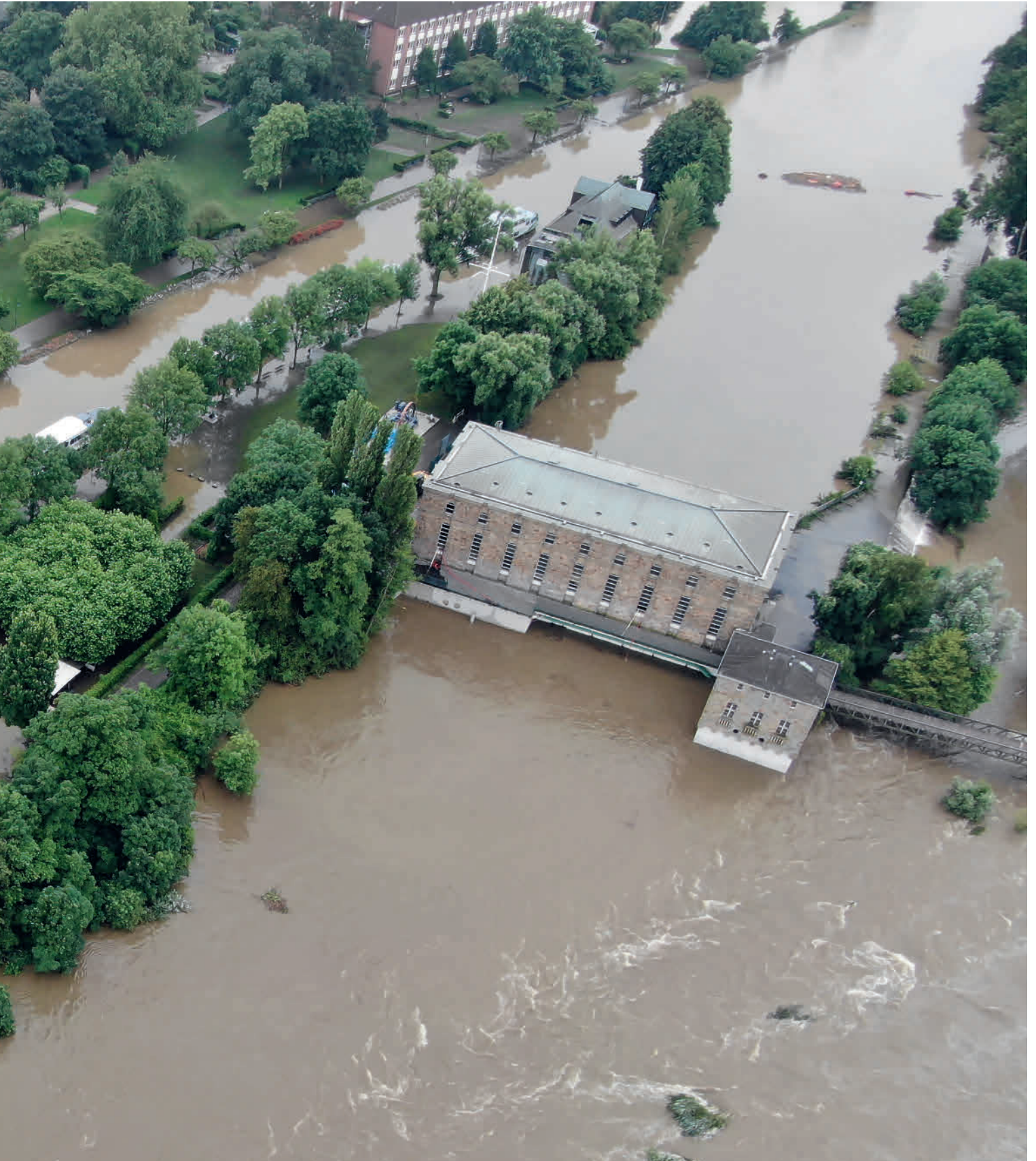
Überflutete Schleuseninsel in Mülheim an der Ruhr am Kraftwerk Kahlenberg der RWW während des Hochwassers im Juli 2021 (Bild: RWW)
