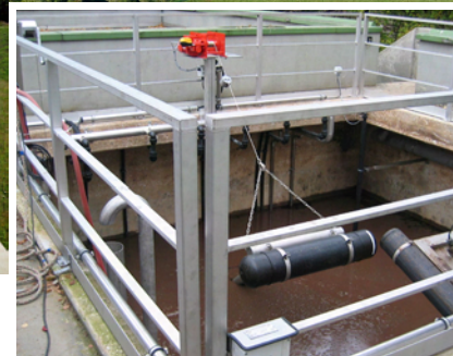
Schlammwasserbehandlung im Nebenstrom durch Deammonifikation
