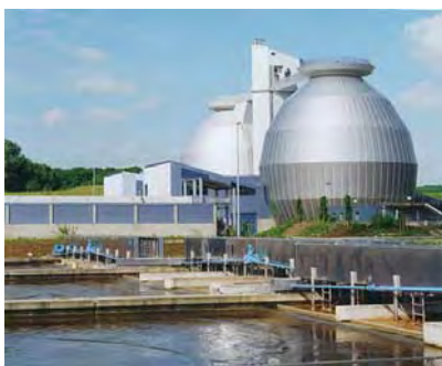
Abb. 6.14-1: Faulbehälter der KA Bochum Ölbachtal
