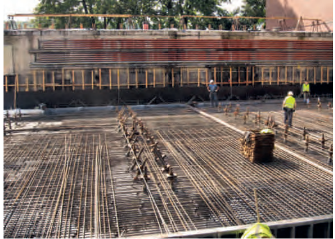
Bild 16.11: Baugrube vor vorhandenem Pumpwerk Fig. 16.11: Construction area in front of an existing pumping station
