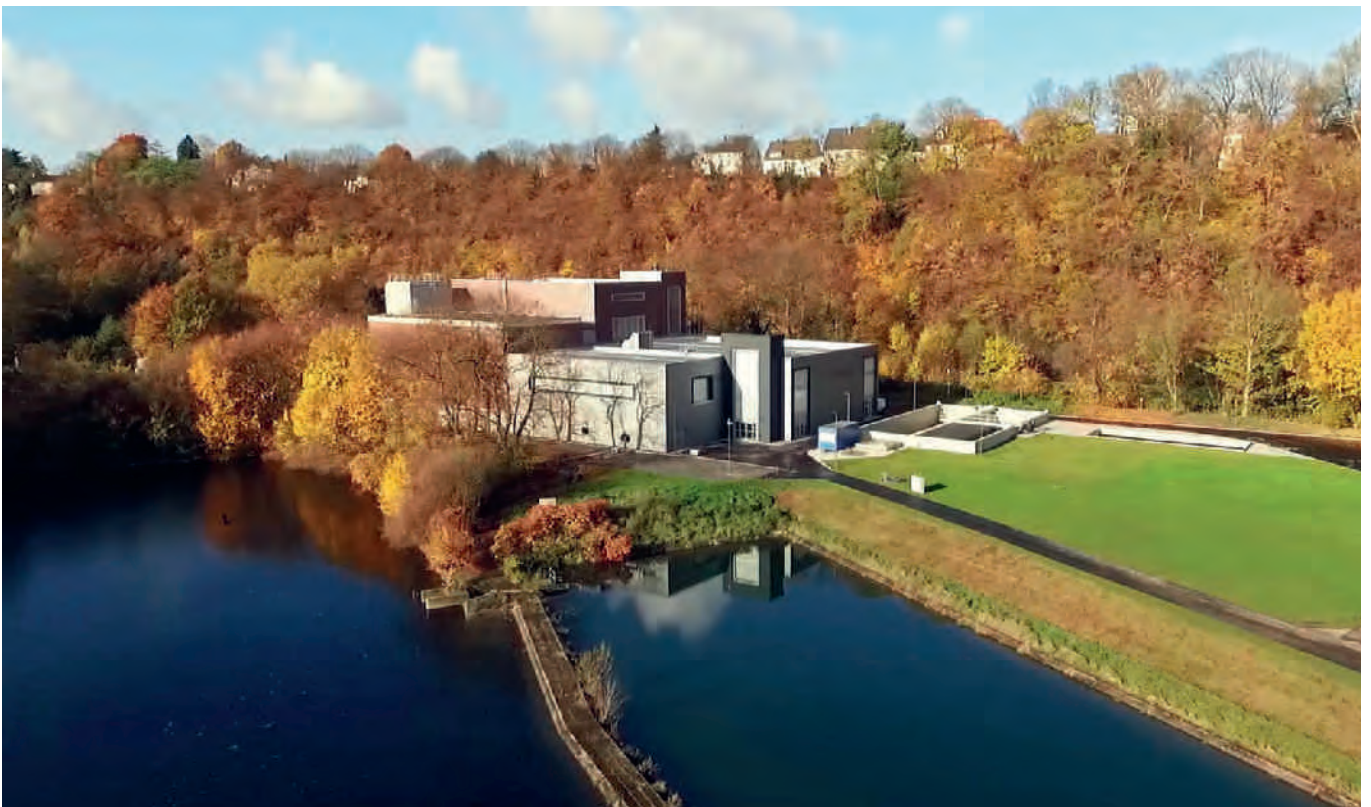
Bild 16.14: Wasserwerk Witten mit der weitergehenden Aufbereitung Fig. 16.14: Waterworks Witten with the extended treatment
