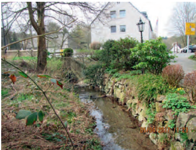
Bild 4.16: Leiße oberhalb RÜ 1 Post: Das Gewässer ist auf Grund der eng angrenzenden Bebauung als HMWB mit der Fallgruppe „Bebauung ohne Vorland“ ausgewiesen und entsprechend im Uferbereich befestigt.
