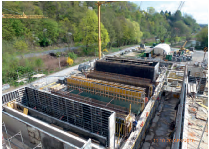
Bild 16.12: Rohbau Adsorptionsgebäude Fig. 16.12: Construction site of the adsorption building
