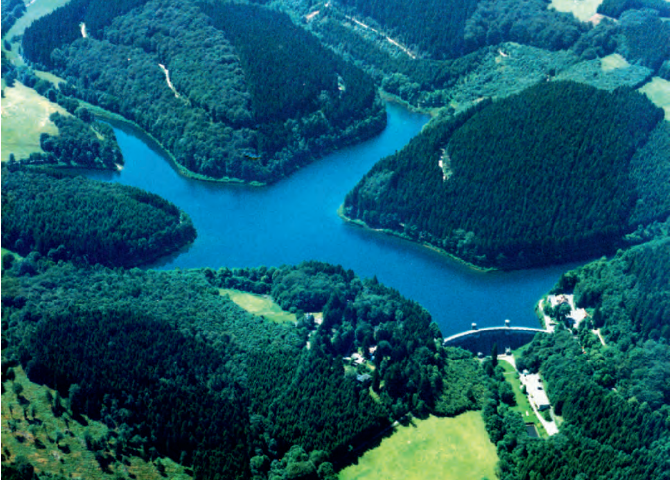
Bild 6.2: Luftaufnahme der Fürwiggetalsperre Fig. 6.2: Aerial photograph of the Fürwigge Reservoir
