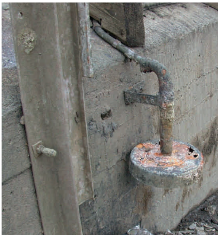
Bild 16: Ausperltopf unbekanntes Alters der Möhnetalsperre vor dem Austausch
