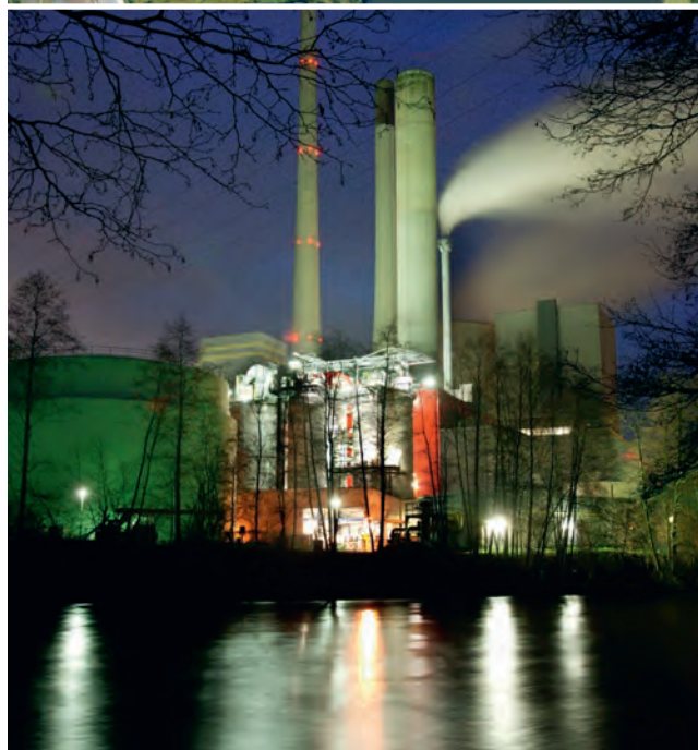
Oben: Kläranlage Essen-Kupferdreh unten: Schlammverbrennungsanlage Elverlingsen.
