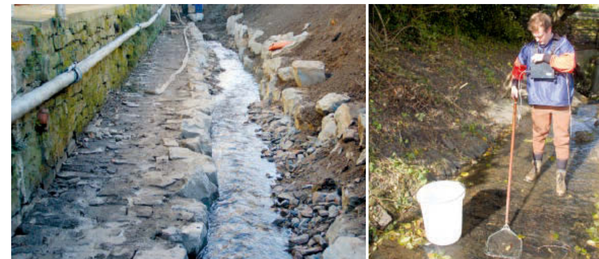
Links: Der renaturierte Abschnitt des Sprockhöveler Bachs in der Bauphase. Rechts: Probefischung.
