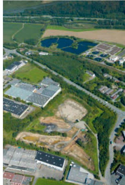
Schlammplätze der Kläranlage Arnsberg-Neheim.
