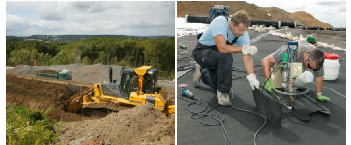
Die Oberflächenabdichtung (rechts) verhindert, dass Niederschlagswasser in den Deponiekörper der stillgelegten Deponie Griesenbrauck (links) einsickert.
