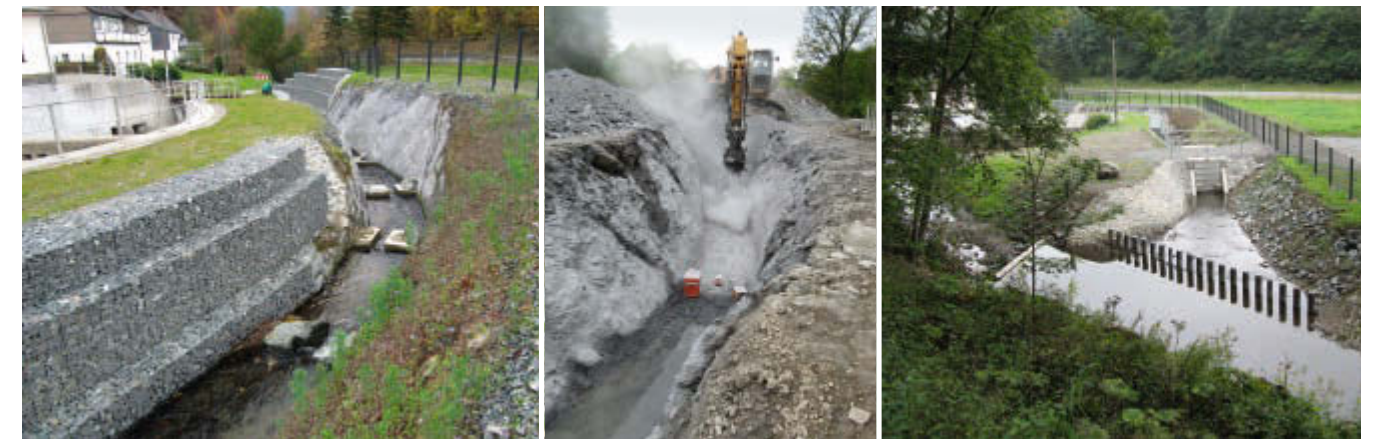
Links: Die neue Fischwanderhilfe mit Gabionenwand und Felsbereich. Mitte: Felsbau im Gerinne. Rechts: Blick auf den Einlaufbereich.
