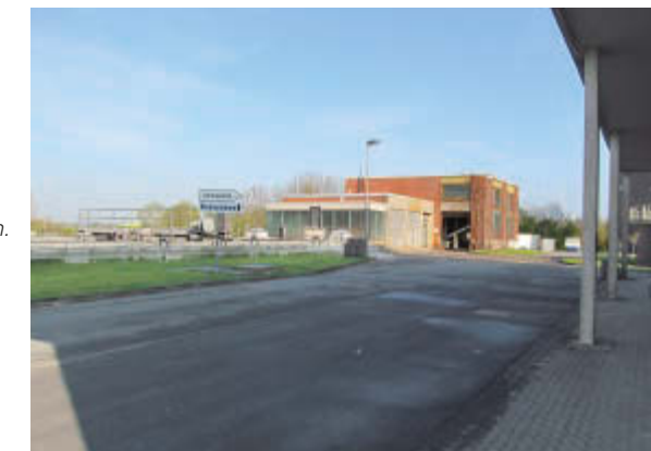
Rechengebäude der Kläranlage Paderborn.
