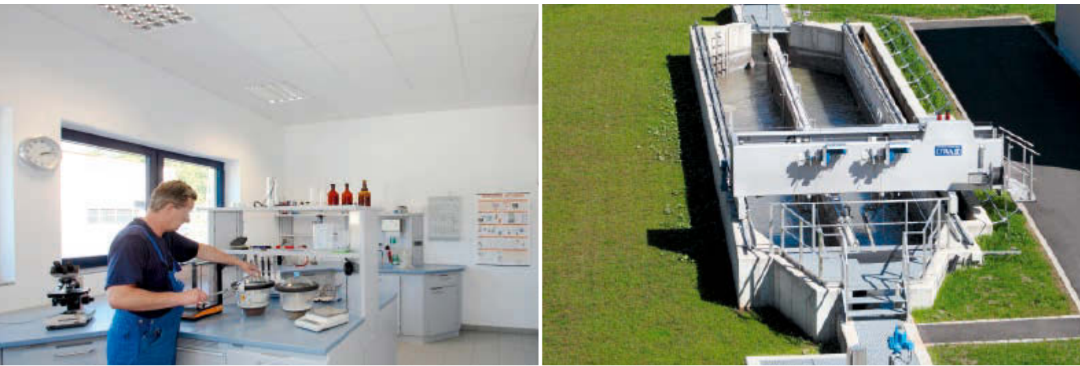
Blick ins Labor (l.) und auf den Sandfang (r.) der Kläranlage Wenden.
