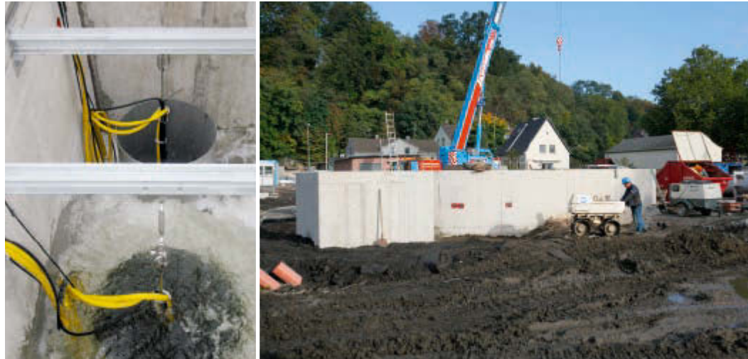
Links: Funktionsprüfung des neuen Pumpwerks Westfalenstraße. Rechts: Das Pumpwerk im Bau.
