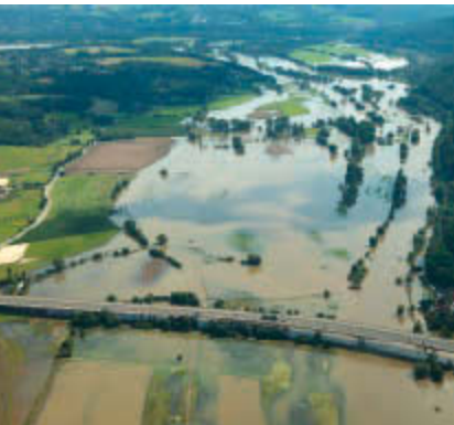
Hochwasser an der Ruhr.
