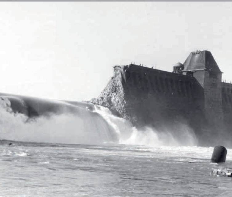
Durch eine 77 Meter breite Lücke strömte das Wasser aus der Talsperre.
