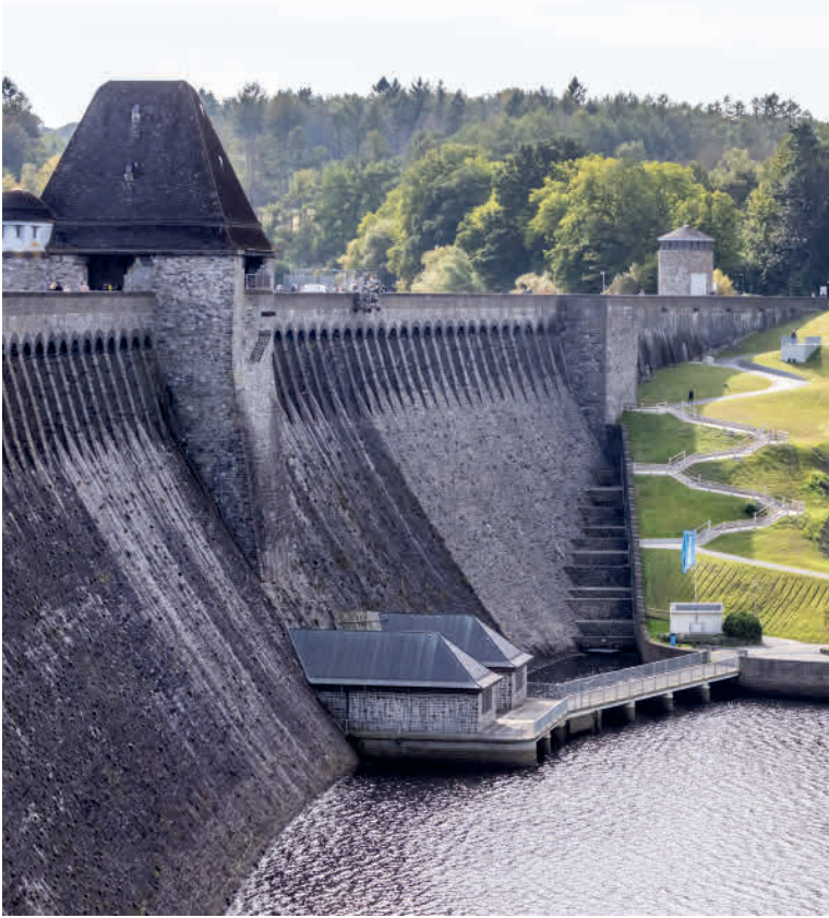
Die Staumauer wurde aus Bruchsteinen gebaut.
