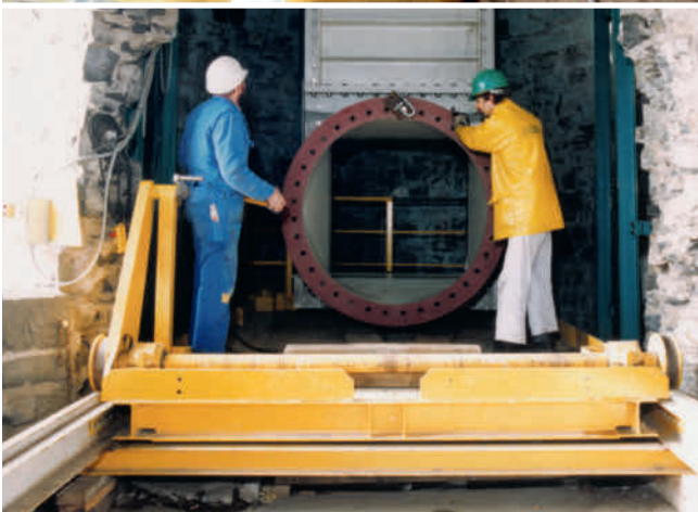
In den 1970er-Jahren wurde ein Kontrollstollen durch die Staumauer getrieben (Bild oben). Die Grundablässe (mittleres und unteres Bild) wurden in den 1990er Jahren erneuert.
