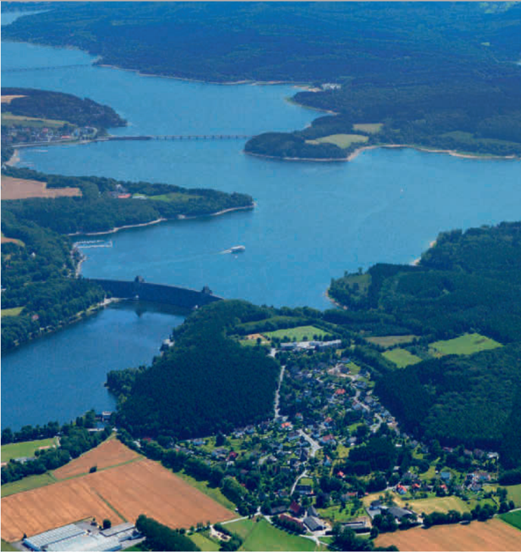
Die Möhnetalsperre ist die flächenmäßig größte Talsperre des Ruhrverbands.
