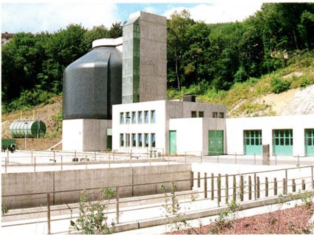
Faulbehälter, Betriebsgebäude und Regenüberlaufbecken
