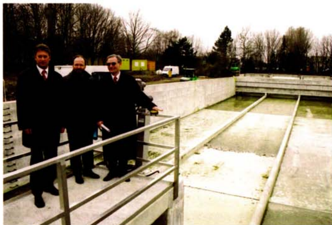
Inbetriebnahme der 500. Niederschlagswasserbehandlungsanlage (RÜB Eibergbach) im März 2002
