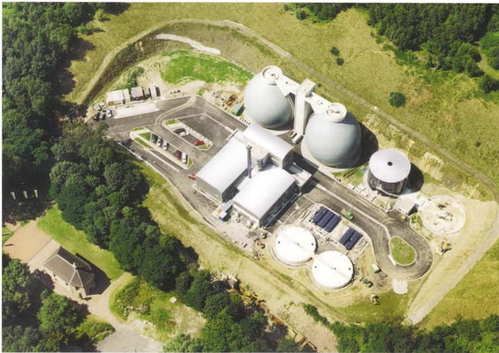
Die neue zentrale Klärschlammbehandlungsanlage Langenbrahm für den Essener Süden
