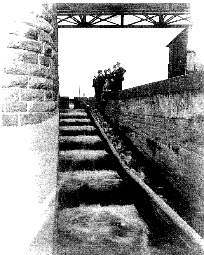
Bild 12.5: Fischweg am Wehr in Mülheim-Raffelberg (1919 fertig gestellt), aufgenommen bei der Besichtigung durch die Ruhrfischereigenossenschaft am 29. Mai 1920
