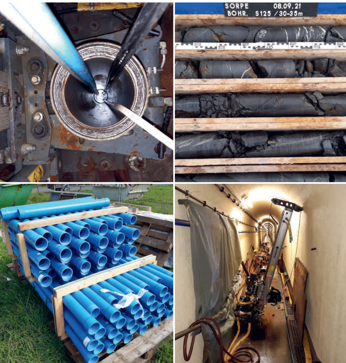
Am Absperrbauwerk der Sorpetalsperre wurde im Mai 2021 mit der Sanierung der Drainage- und Kontrollbohrungen begonnen.
