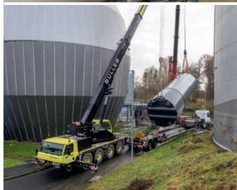
Oben: Erneuerung der Druckrohrleitungen des Pumpwerks Oberhausen-Kewerstraße. Links unten: Anlieferung und Montage eines neuen Klärschlammstilos für die Kläranlage Bochum-Ölbachtal Rechts unten: Die neue Deammonifikationsanlage sorgt auf der Klärschlammbehandlungsanlage Essen-Langenbrahm für eine effektive Stickstoffelimination.
