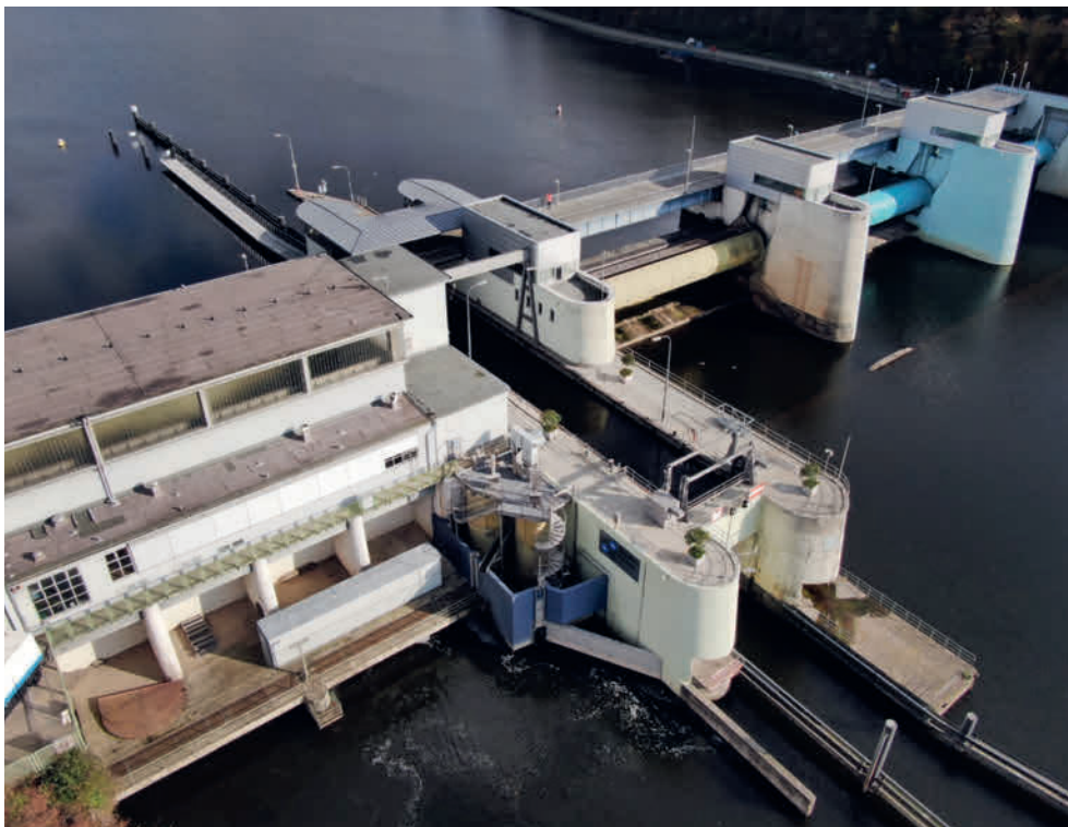
Das Fischliftsystem am Baldeneysee ist als Prototyp eine neue platzsparende Möglichkeit, um die Fischwanderung an größeren Stauwehren zu realisieren. Bereits in der einjährigen Einstellphase nutzten knapp 20.000 Fische den Lift.
