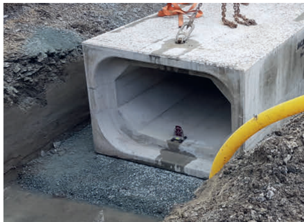
Sanierung im Schmallenberger Ortsteil Westfeld: Einbau eines Rahmenprofils 1.250 x 750 mm mit Auslass zur Lenne.
