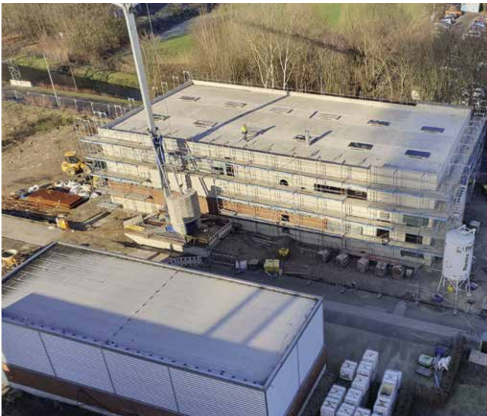
Der Bau der neuen Multifunktionshalle in Bottrop, die die Demonstrationsanlage zur Phosphorrückgewinnung künftig beherbergen wird, schreitet stetig voran.
