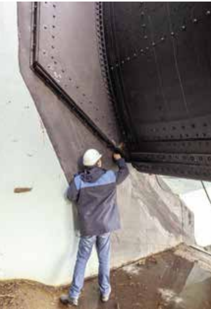
100 Tonnen wiegt jede einzelne Wehrwalze am Baldeneysee. Die Walze in Wehrfeld 3 (o. r.) wurde ab Januar 2022 stahlbau- und korrosionsschutztechnisch instandgesetzt.
