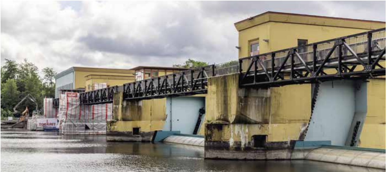
Oben: Die Sanierung der Wehranlage Hengsteysee wurde fortgesetzt und wird voraussichtlich noch bis ins Jahr 2026 dauern.
